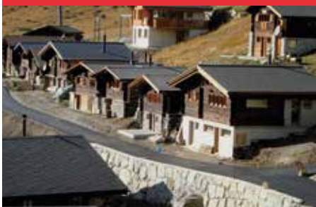
Neubau einer Erschliessungsstrasse, Lauchernalp.
